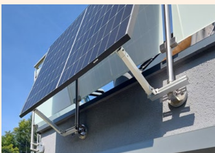
Ein durchgängiges MiniTec-Profil ersetzt zu kurze mitgelieferte Befestigungen.
