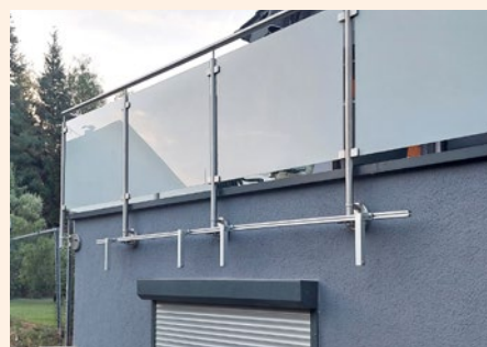
Ein durchgängiges MiniTec-Profil ersetzt zu kurze mitgelieferte Befestigungen.
